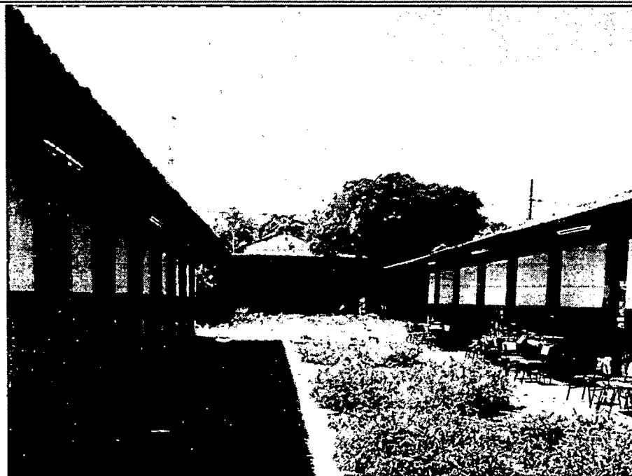
Descrição: PÁTIO ENTRE BLOCOS DE AULAS EXISTENTES - ESCOLA CORONEL SIMÃO CAMPOS
