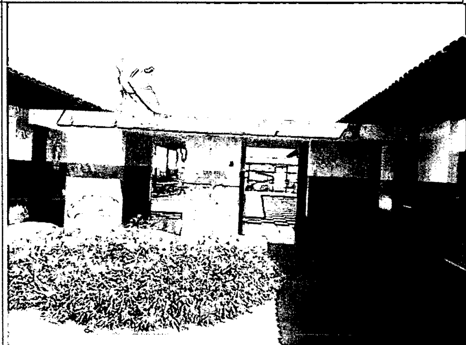
Descrição: CIRCULAÇÃO ENTRE OS BLOCOS - ESCOLA CORONEL SIMÃO CAMPOS
